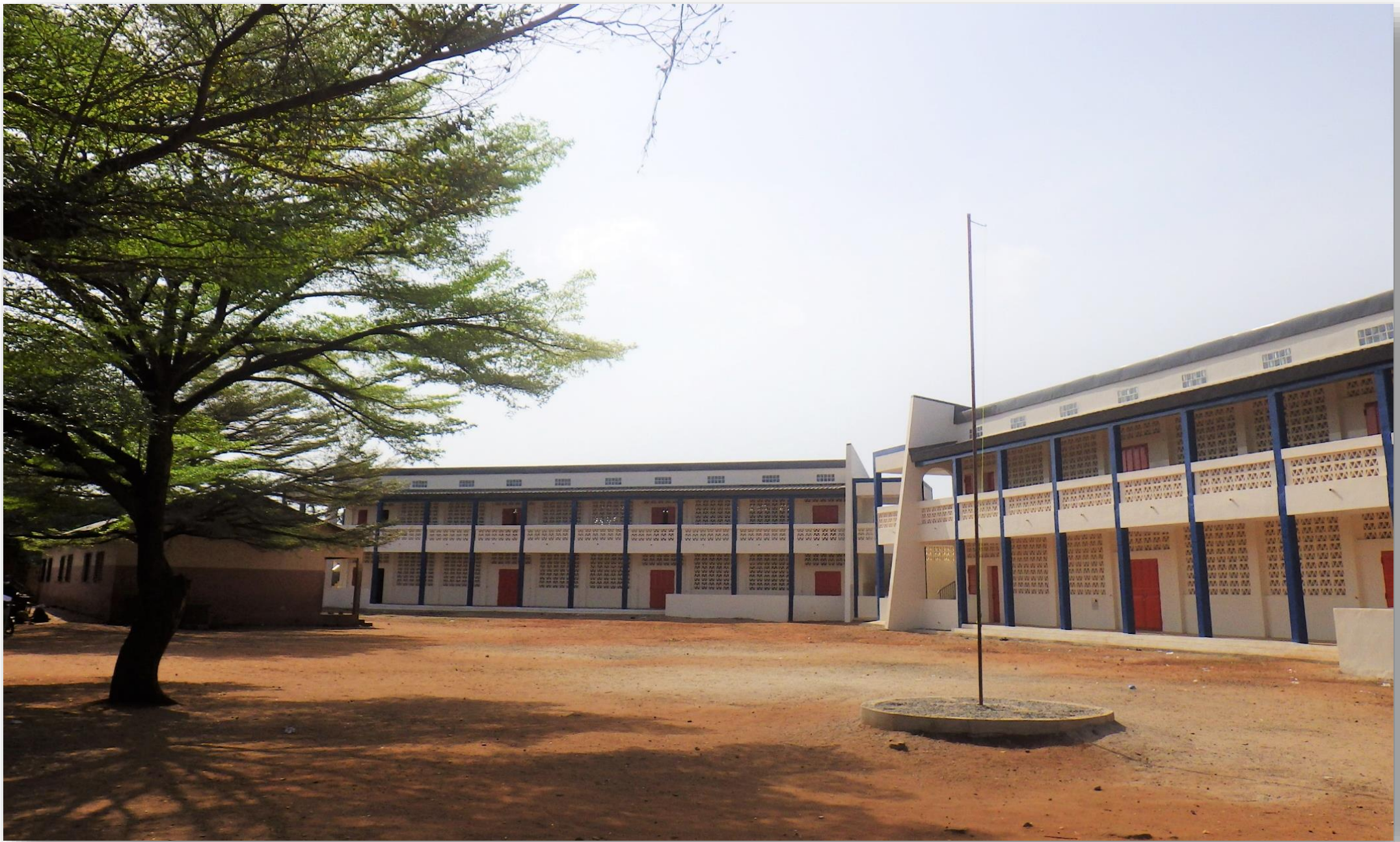
<Salles de classe nouvellement construites à l'EPP de FONSRAME à OUIDAH >
