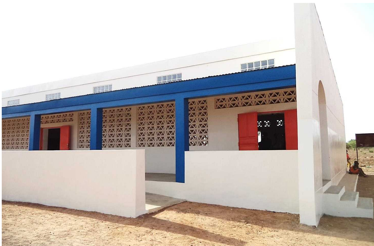
<Module de salles de classe construit par le Japon au même type à Coby>
